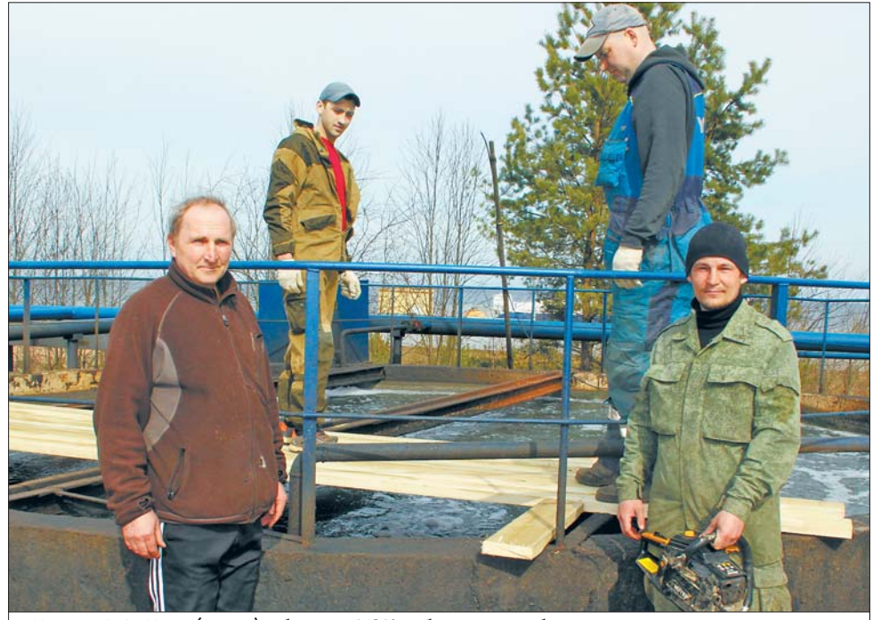
Мастер А.А. Марк (слева) и бригада ИЭК работают на лебяженских очистных
