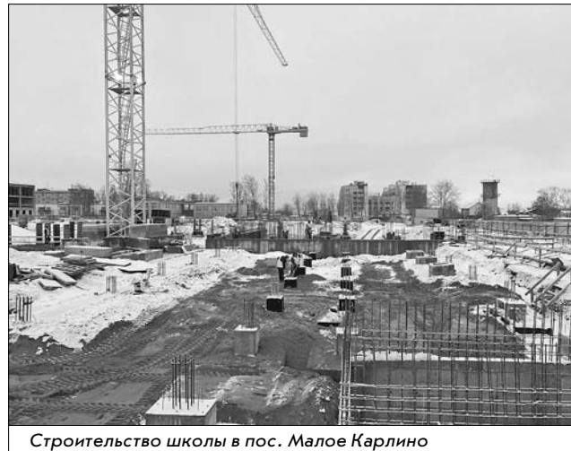
Строительство школы в пос. Малое Карлино
