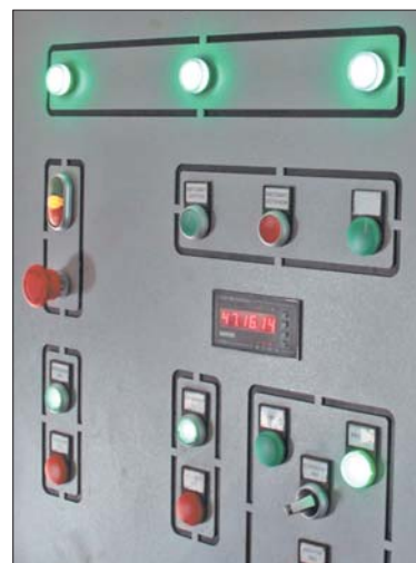
Пульт управления новой линии обработки ТКО
